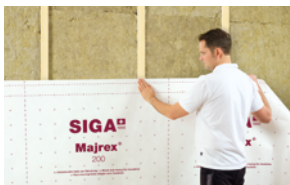
Montage Dampfbremse auf Holzkonstruktion
