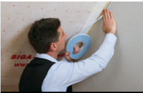
Dampfbremse an Massivbauwand
