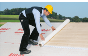
Montage Dampfbremse bei Aufsparrendämmung
