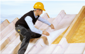
Montage Dampfbremse bei geschlauerter Dachsanierung von aussen
