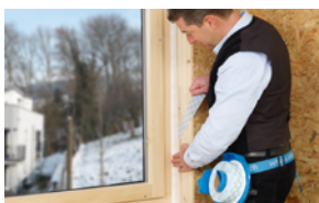
Fenster an Holzbauwand
