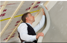
Montage Dampfbremse bei Einblasdämmung
